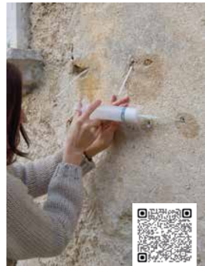
Putzkonsolidierung in Kalktechnologie © Bundesdenkmalamt
