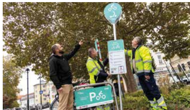
Bauhof-Leiter Stefan Prem und sein Team sorgen dafür, dass die neuen Baden mobil-Tafeln im gesamten Stadtgebiet aufgestellt werden.
