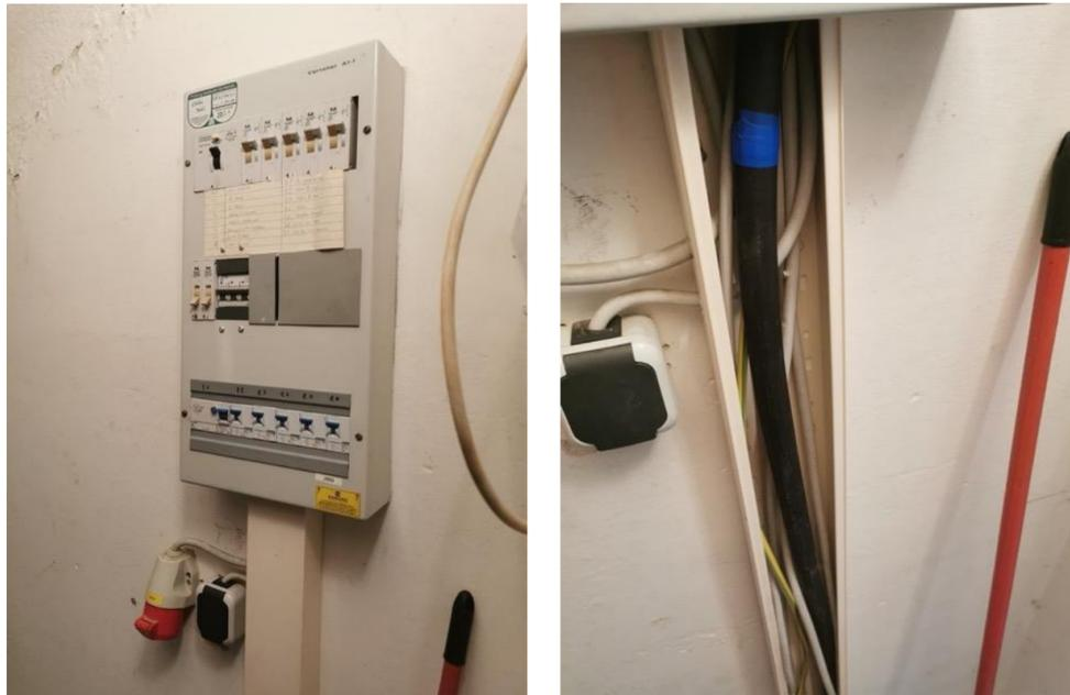
Verteiler und Zuleitung im Abstellraum des Westtraktes. Hier werden zwei neue WR montiert und angeschlossen
