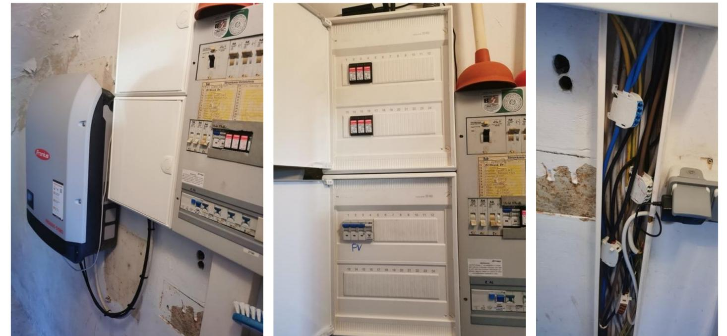
Bestehende Anlage im Osttrakt, die um einen weiteren WR erweitert wird
